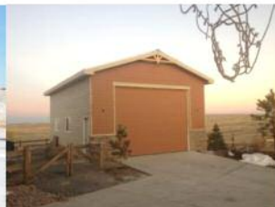
24x32 Hardi-Plank Siding - Parker
